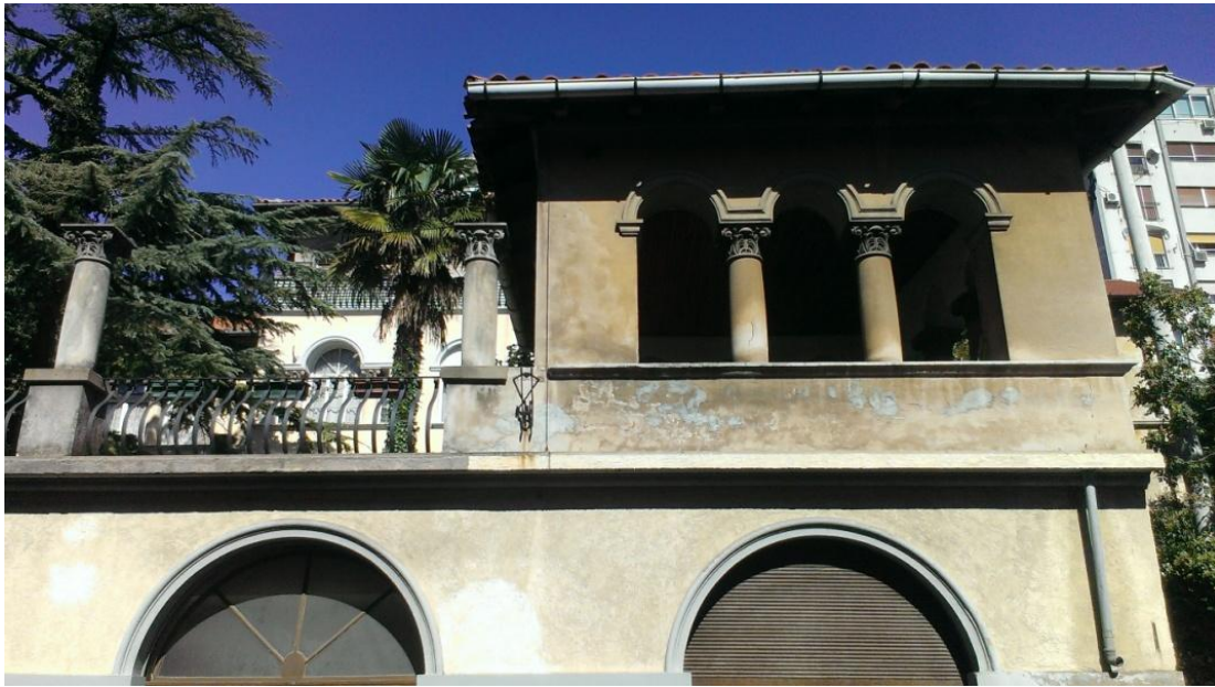
Vila Kezele - Pročeljni dio uz cestu sa poslovnim prostorima i terasom, detalj (f.S.M.)
