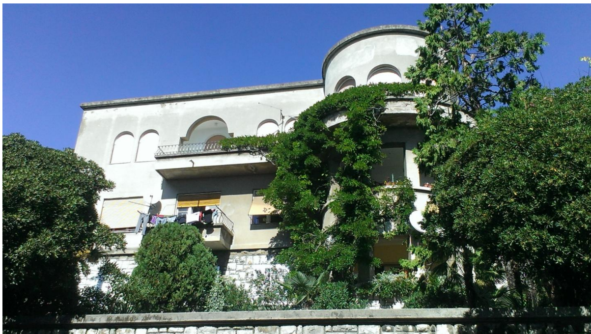
Vila Braun – pročelje – JZ dio (f.S.M)
