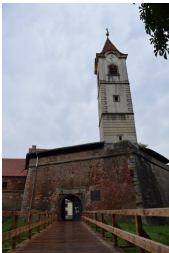
Slika 15. Ulazni bastion utvrde Čakovec, Snimila: Simona Košnjak
