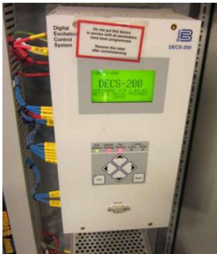
Slika 9 Automatski regulator napon
